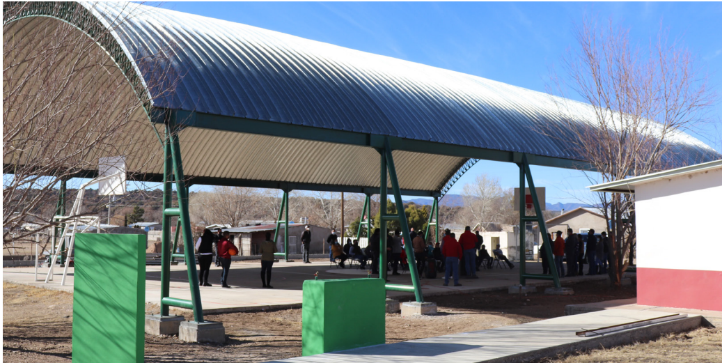
Construcción de domo en Secundaria No. 6047
